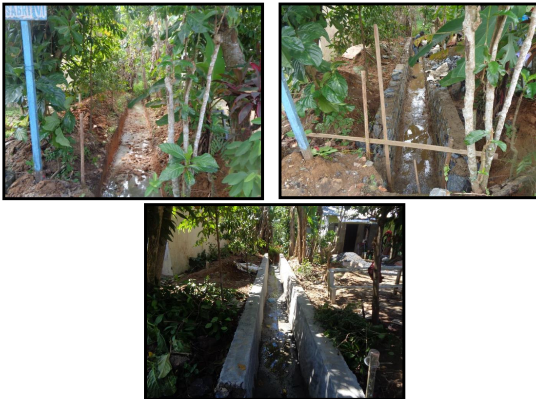
Gambar 3.5 Pembangunan Drainase Komplek Asabri RT. 18 RW. 04 Kel. Sungai Ulin Kec. Banjarbaru Utara
