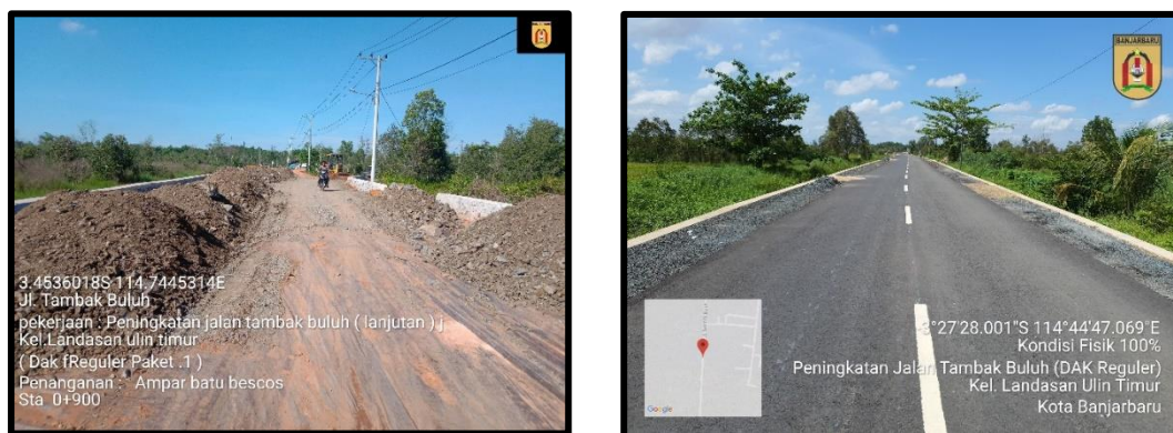
Gambar 3.6 Peningkatan Jalan Tambak Buluh (lanjutan) Kel. Landasan Ulin Timur (DAK Reguler Paket 1)
