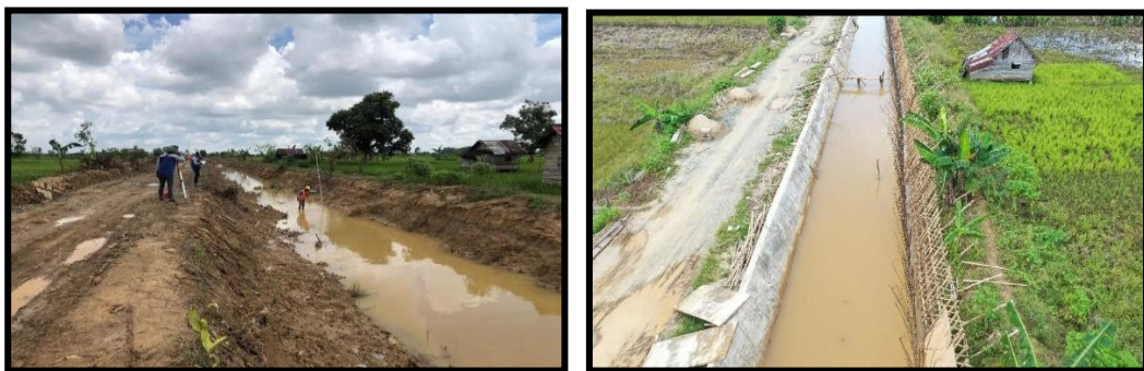
Gambar 3.2 Rehabilitasi Jaringan Irigasi DI. Bangkal (DAK Penugasan)
