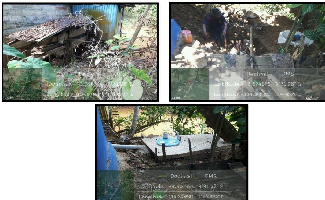
Gambar 3.4 Pembangunan Tangki Septik Skala Individual Perkotaan Kel. Bangkal Kec. Cempaka
