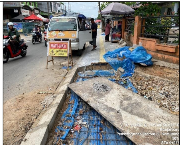
3° 26' 37" S, 114° 49' 50" E Kota Banjarbaru Pembangunan Trotoar Jl. Kemuning STA 0+075
